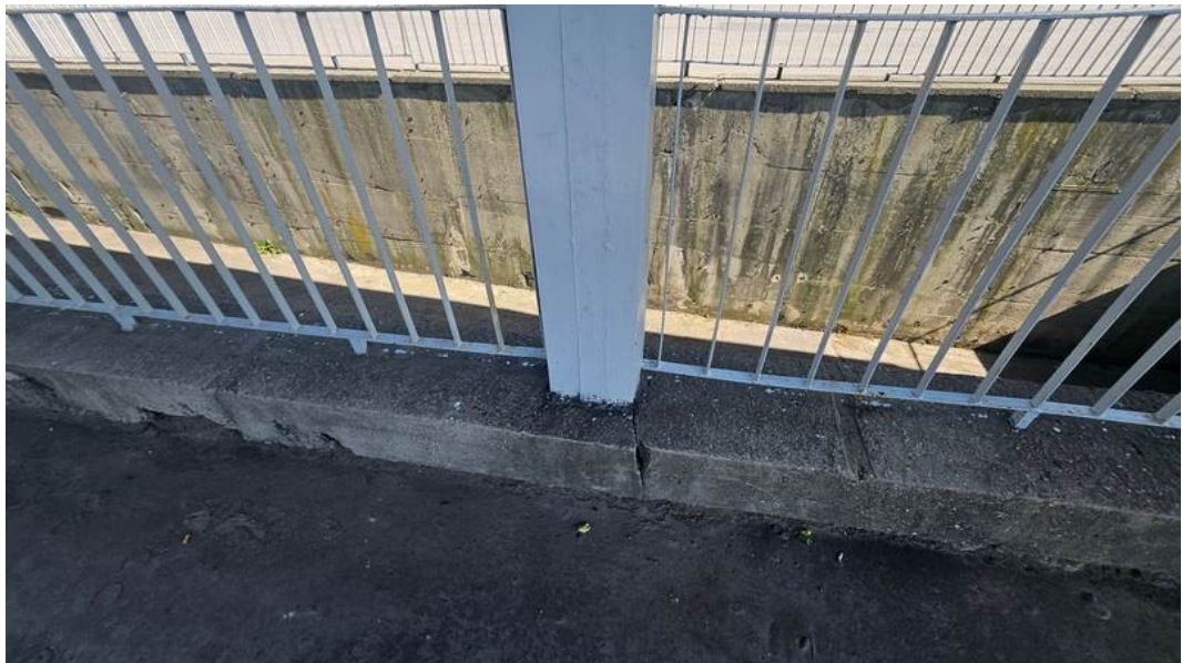
Fot. 7 Słup na ścianie oporowej zjazdu wiaty 0
