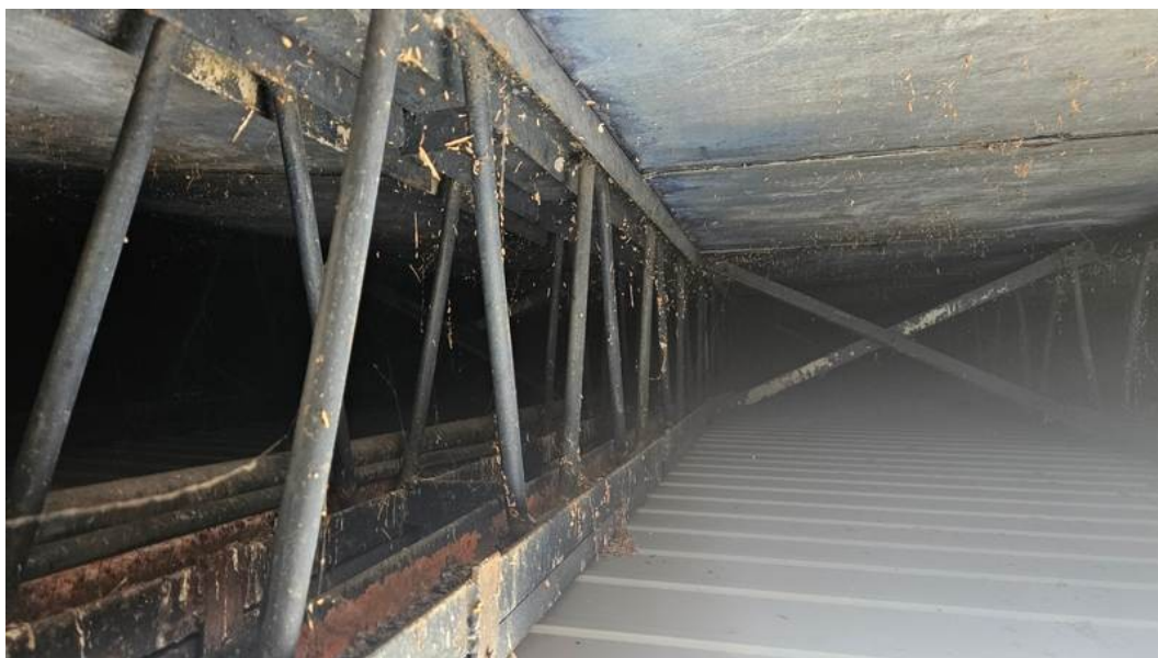
Fot. 5 Dźwigar wzdłużny
